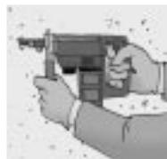
Realizar la perforación con agujereadora según el diámetro y profundidad adecuados según cálculo.
