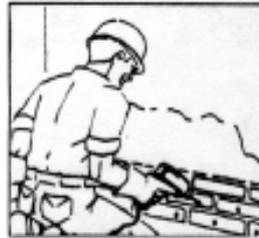
B) Realizar dos hileras de perforaciones. La primera a una altura del piso similar al espesor de la pared, y la segunda a 10cm de la inferior. Los orificios se deberán ubicar de manera alternada los de una hilera con respecto de la otra, y separados entre sí de 20 a 30 cm. Las perforaciones se harán a 45° de la pared con una profundidad mínima de dos tercios del espesor del muro.
