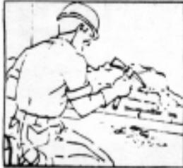
A) Picar el revoque existente superando la altura de lo deteriorado por la humedad ascendente.
