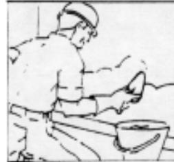
D) A partir de las 48Hs. de ejecutada la infiltración se puede completar el trabajo realizando el revoque con **SIKA1** ó aplicando **SIKA MONOTOP 107**.
