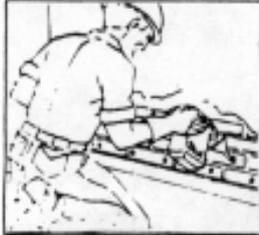
C) Introducir recipientes tipo embudo en los orificios y colocar **INERTOL INFILTRACIÓN** dejando que penetre el consumo indicado para cada tipo de pared.
